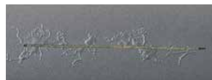
Fig 3. Filiformkorrosion vid rits på en lackerad aluminiumdetalj efter ACT-provning.
